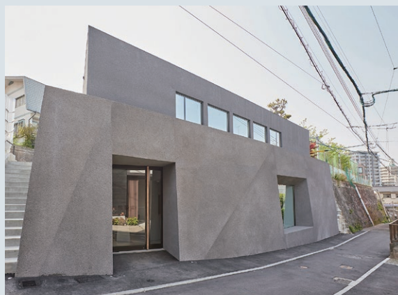
周囲の石垣擁壁に調和しながらも、彫刻のような存在感のある 外観。外壁は地元筑後川の砂利を使った左官擁壁。
